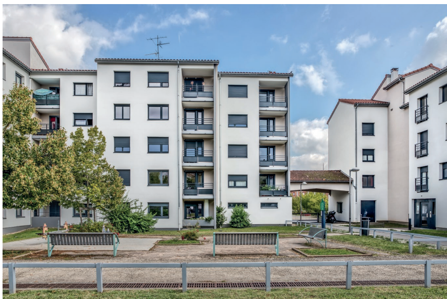
L'Orion, Saint-Genis-Laval (69). Résidence locative sociale de 59 logements - 3 000 m 2 . Système Revitherm EP pour l'ensemble des façades avec Polystyrène Expansé (PSE) blanc, en calé/chevillé et finition Crépi Initex 2.0 SEIGNEURIE® avec parties en soubassement isolées en Aquapanel.
