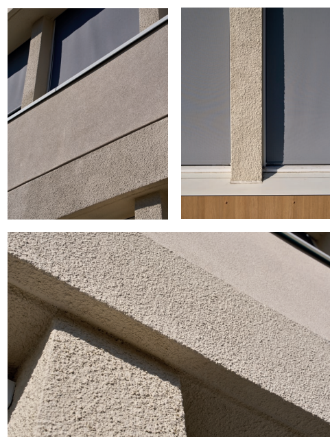
École Montaigne à Saint-Médard-en-Jalles (33). École élémentaire de 1 370 m 2 - Établissement Recevant du Public (ERP). Système Revitherm EP BOIS pour l'ensemble des façades, avec finition Crépi Initex 2.0 SEIGNEURIE®. Système recommandé pour le neuf et la rénovation de tous les chantiers de Haute Qualité Environnementale (HQE) à faible impact carbone, et compatible avec une multitude de finitions.
