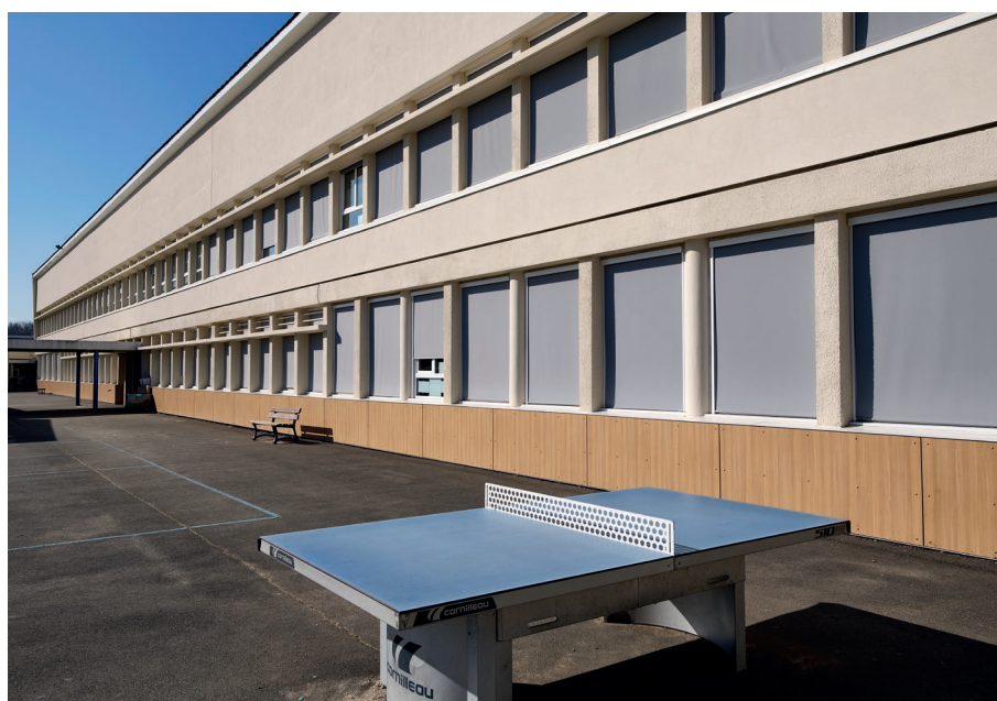
École Montaigne à Saint-Médard-en-Jalles (33). École élémentaire de 1 370 m 2 - Établissement Recevant du Public (ERP). Système Revitherm EP BOIS pour l'ensemble des façades, avec finition Crépi Initex 2.0 SEIGNEURIE®. Système recommandé pour le neuf et la rénovation de tous les chantiers de Haute Qualité Environnementale (HQE) à faible impact carbone, et compatible avec une multitude de finitions.
