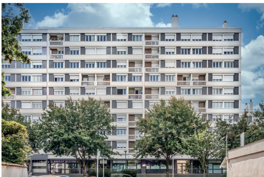
Le Bellemain, Lyon (69). Copropriété de 109 lots - 6 000 m 2 . Système Revitherm EP LM avec Laine de Roche pour l'ensemble des façades, finition Crépi Initex 2.5 SEIGNEURIE®.
