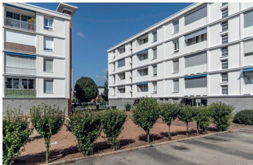
Le Rafour, Bron (69). Copropriété de 261 lots - 5 150 m². Système Revitherm EP pour l'ensemble des façades, avec Polystyrène Expansé (PSE) blanc en 160 mm et finition Crépi Initex 2.0. SEIGNEURIE®.
