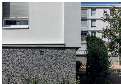
Le Rafour, Bron (69). Copropriété de 261 lots - 5 150 m². Système Revitherm EP pour l'ensemble des façades, avec Polystyrène Expansé (PSE) blanc en 160 mm et finition Crépi Initex 2.0. SEIGNEURIE®.
