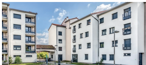
L'Orion, Saint-Genis-Laval (69). Résidence locative sociale de 59 logements - 3 000 m 2 . Système Revitherm EP pour l'ensemble des façades avec Polystyrène Expansé (PSE) blanc, en calé/chevillé et finition Crépi Initex 2.0 SEIGNEURIE® avec parties en soubassement isolées en Aquapanel.
